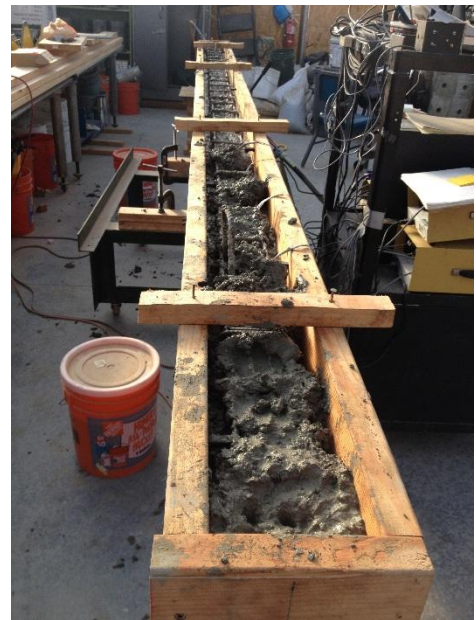
(D) Casting concrete
